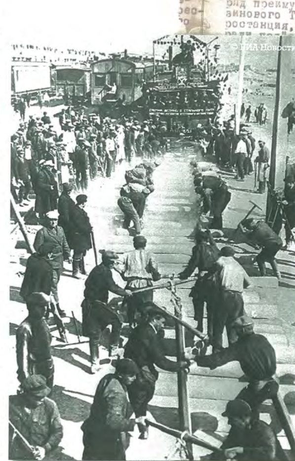
▲ Строители Турксиба (Туркестано-Сибирской магистрали) укладывают последние шпалы перед открытием.
