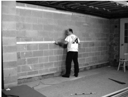
Рис. 1.22. Осторожно устанавливаем планки на стене
