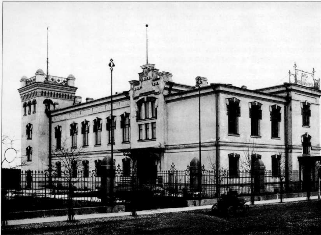
Вид здания, где находился Народный дом Л. Н. Нобеля (Нюстадтская, 19). Фотограф Булла. [1907 г.]
